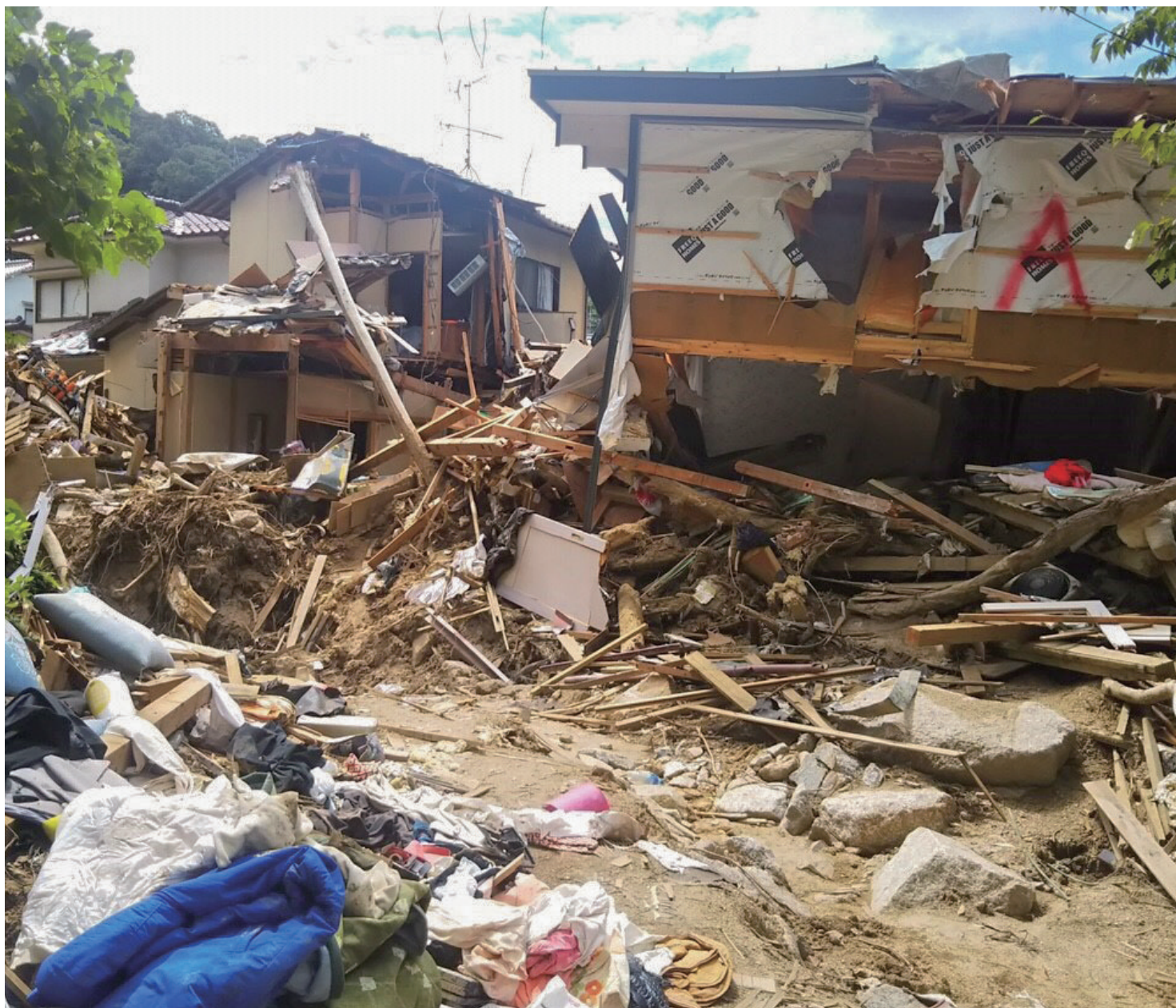
土石流によって倒壊した家屋
