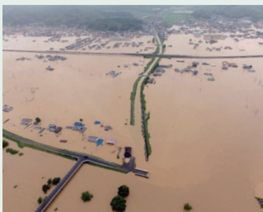
浸水した真備地区の状況(7月7日倉敷市撮影)
