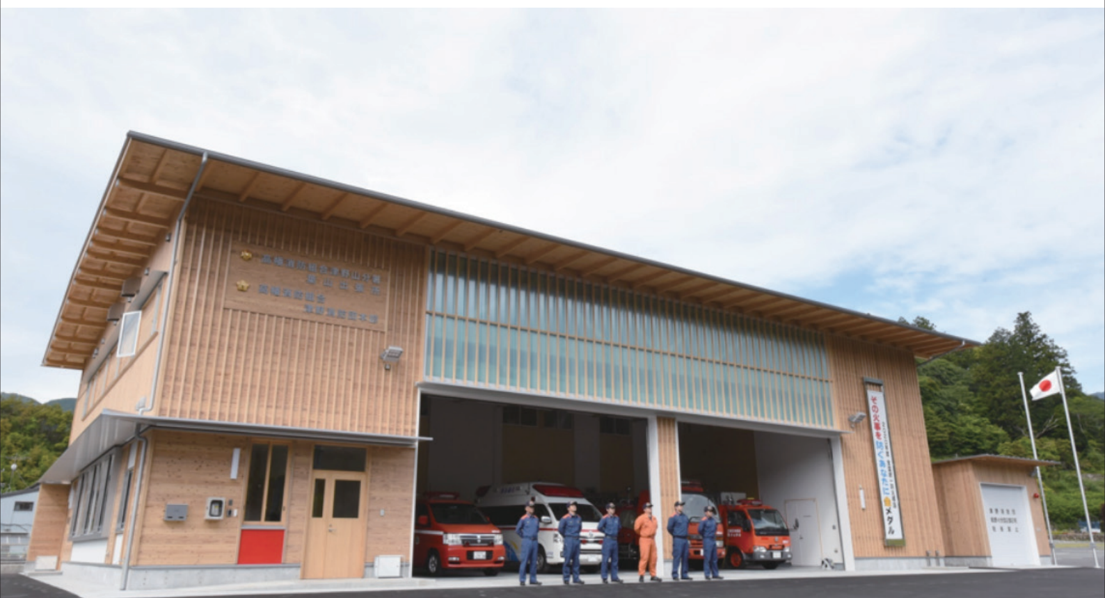
高幡消防組合津野山分署葉山出張所・津野消防団本部新庁舎木造2階建て(一部PH階)延べ面積713.59㎡
