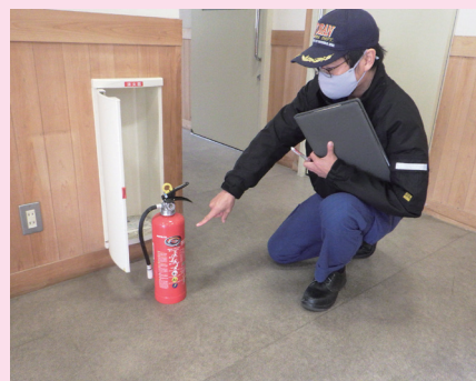
立入検査風景 (消防設備点検中)
