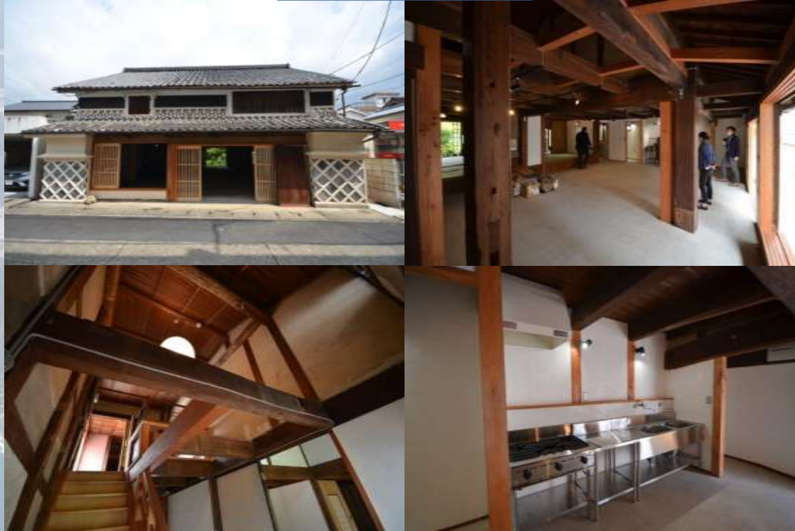
改修後の様子
