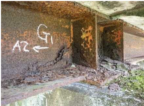
鋼材の腐食
