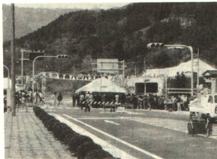
4月2日開通した「吾桑バイパス・吾桑トンネル」
