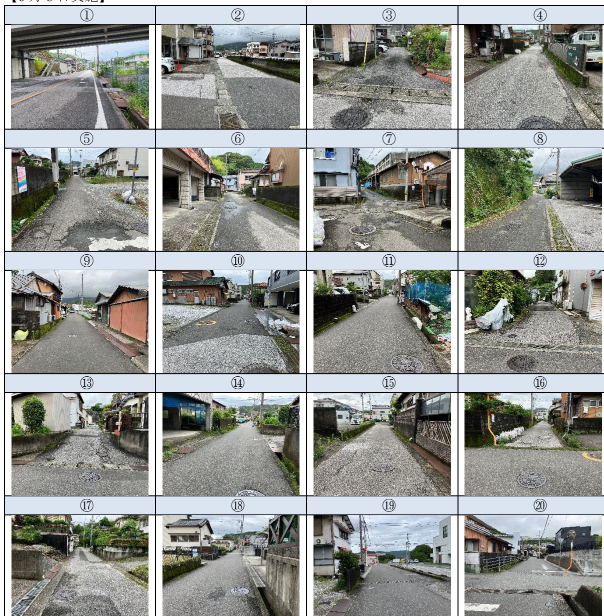
図 5-6 大雨後の巡視 (1/3)
