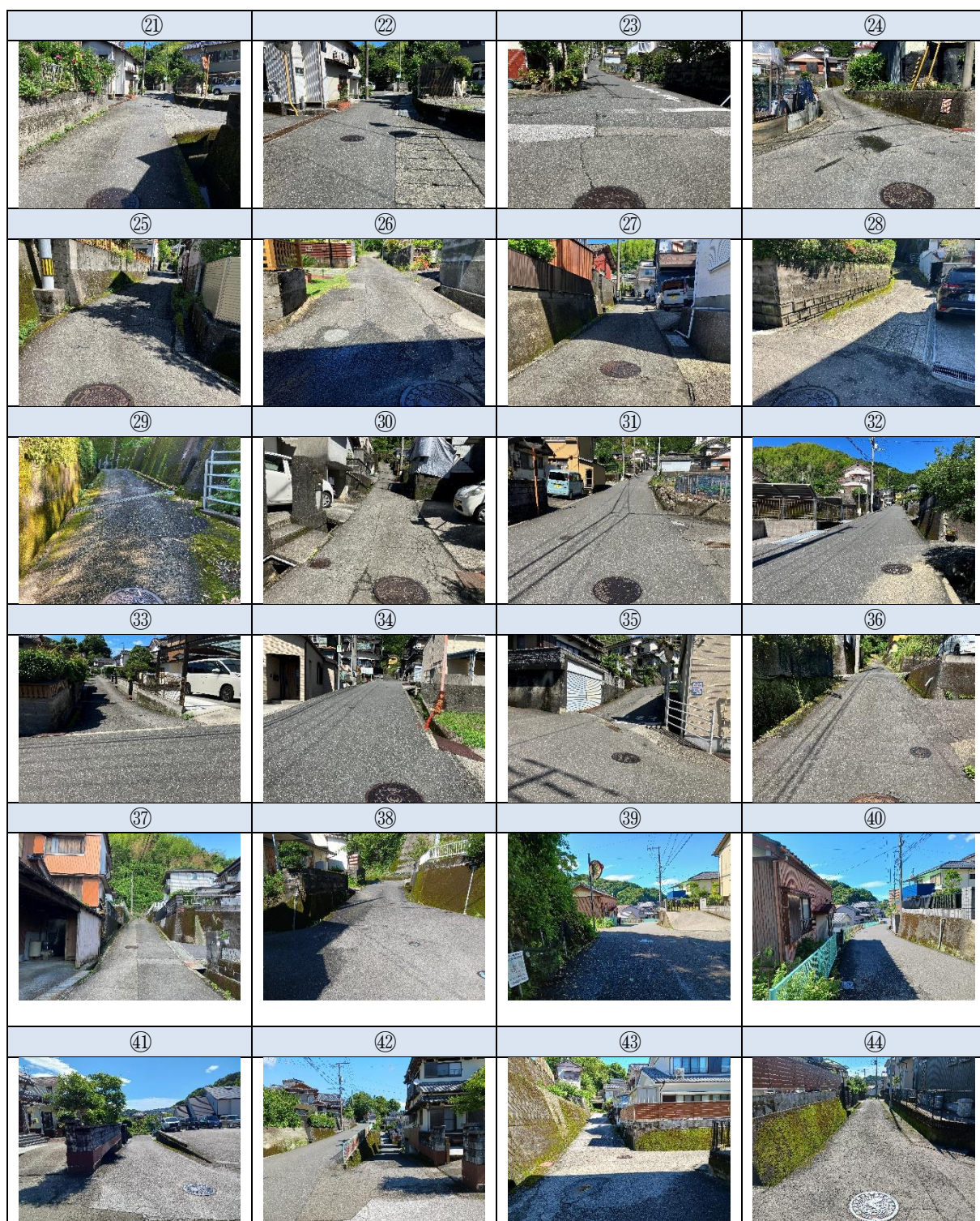
図 5-4 大雨後の巡視 (2/3)
