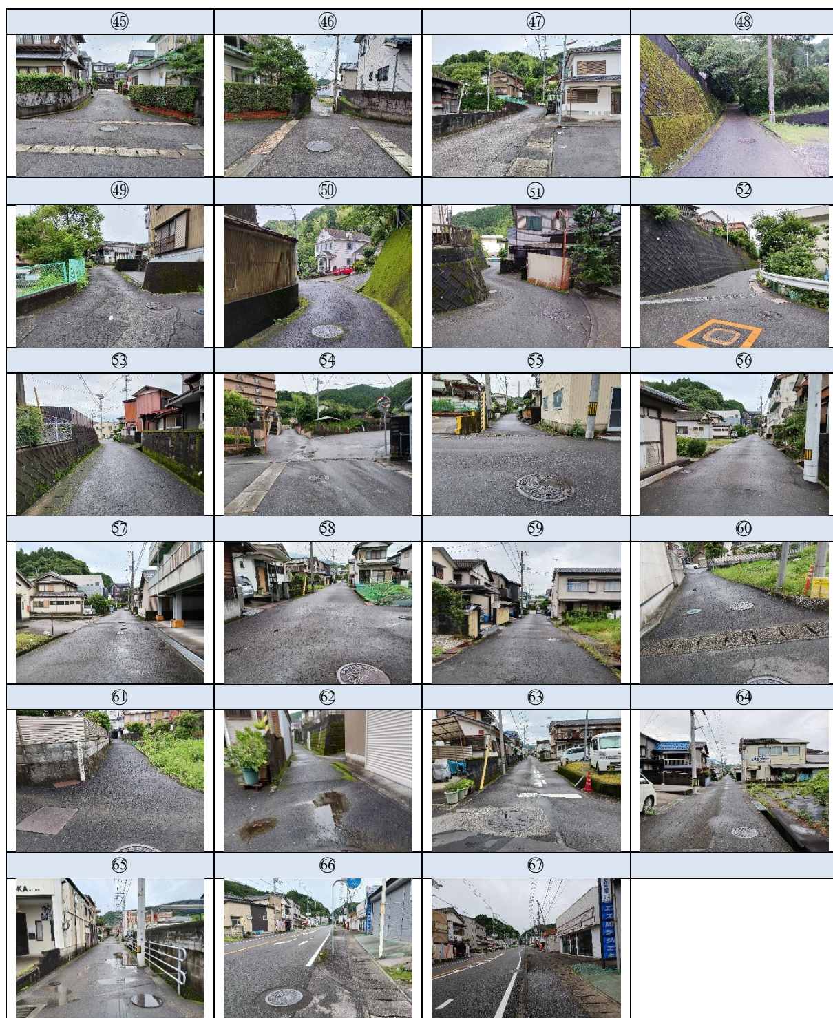
図 5-11 大雨後の巡視 (3/3)
