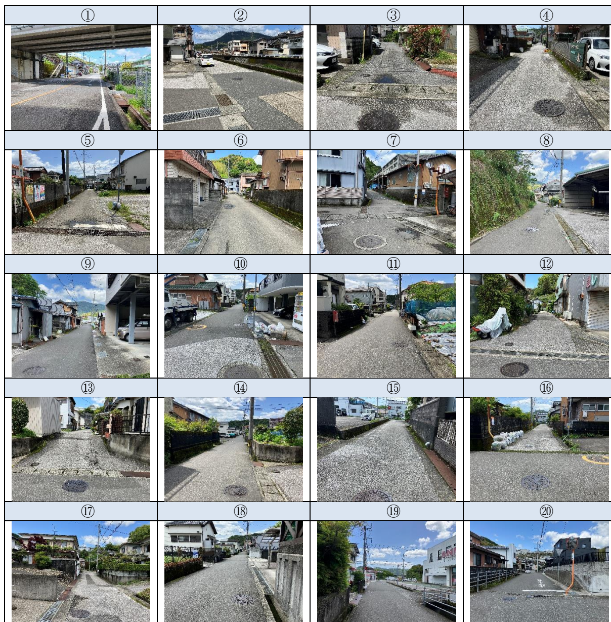
図 5-3 大雨後の巡視 (1/3)
