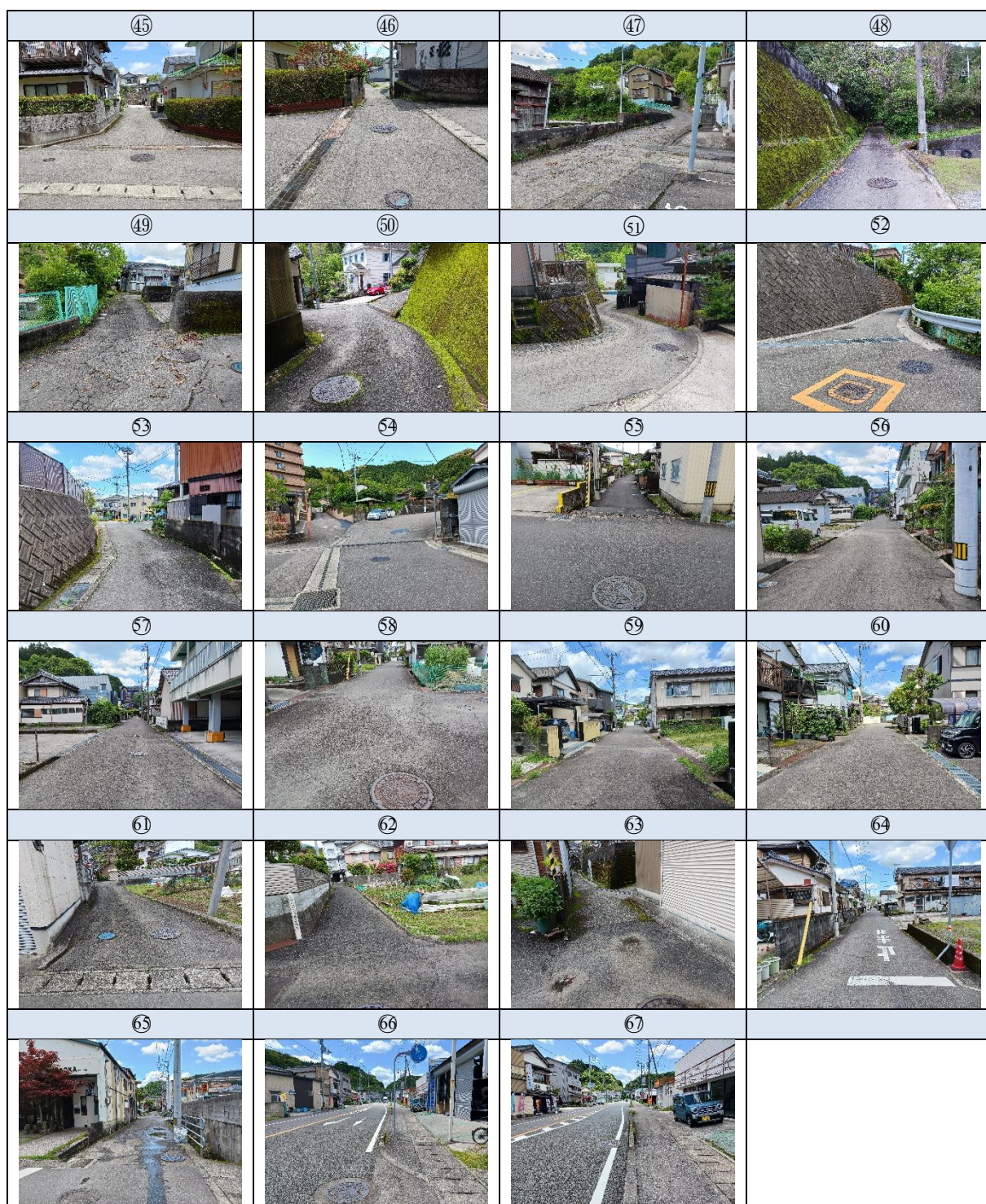
図 5-5 大雨後の巡視 (3/3)
