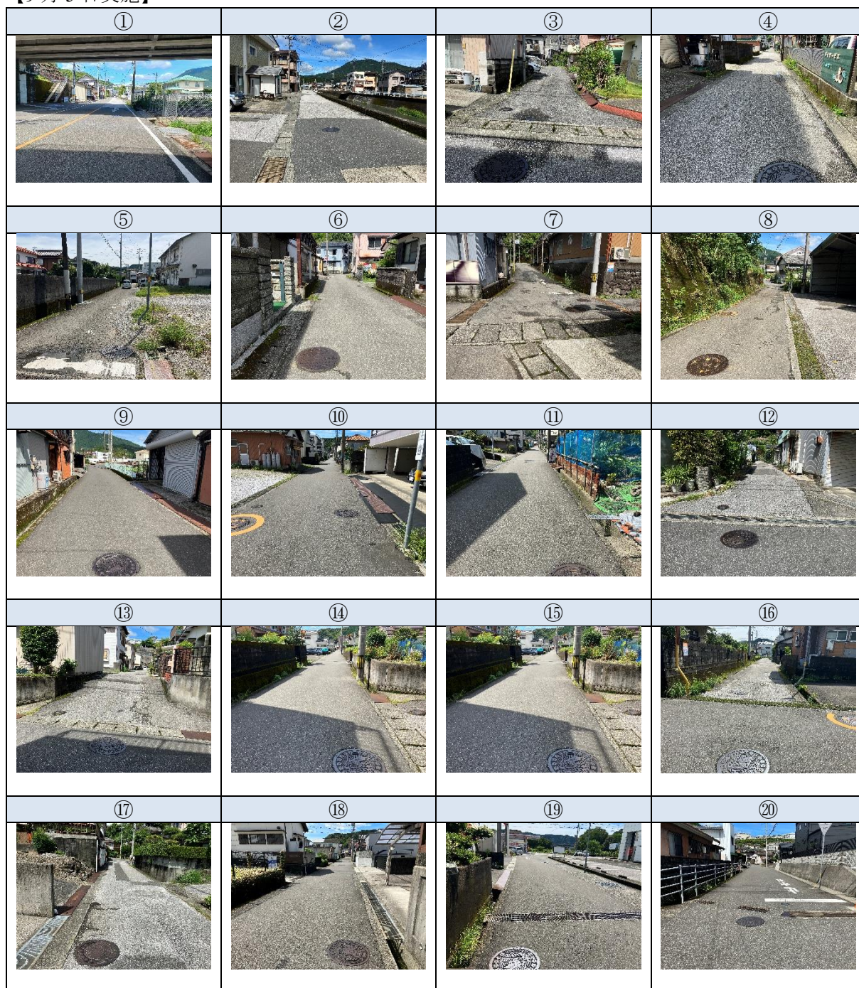
図 5-3 大雨後の巡視 (1/3)
