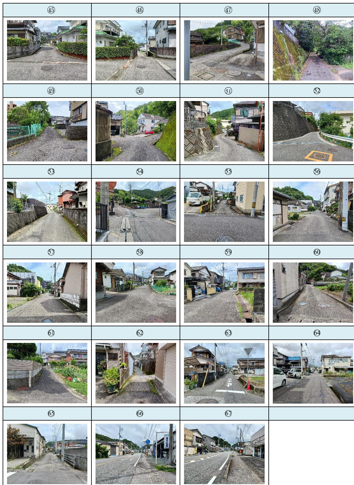
図 5-5 大雨後の巡視 (3/3)
