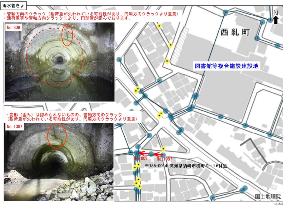
図 5-10 軸方向クラック及び変形状況図
