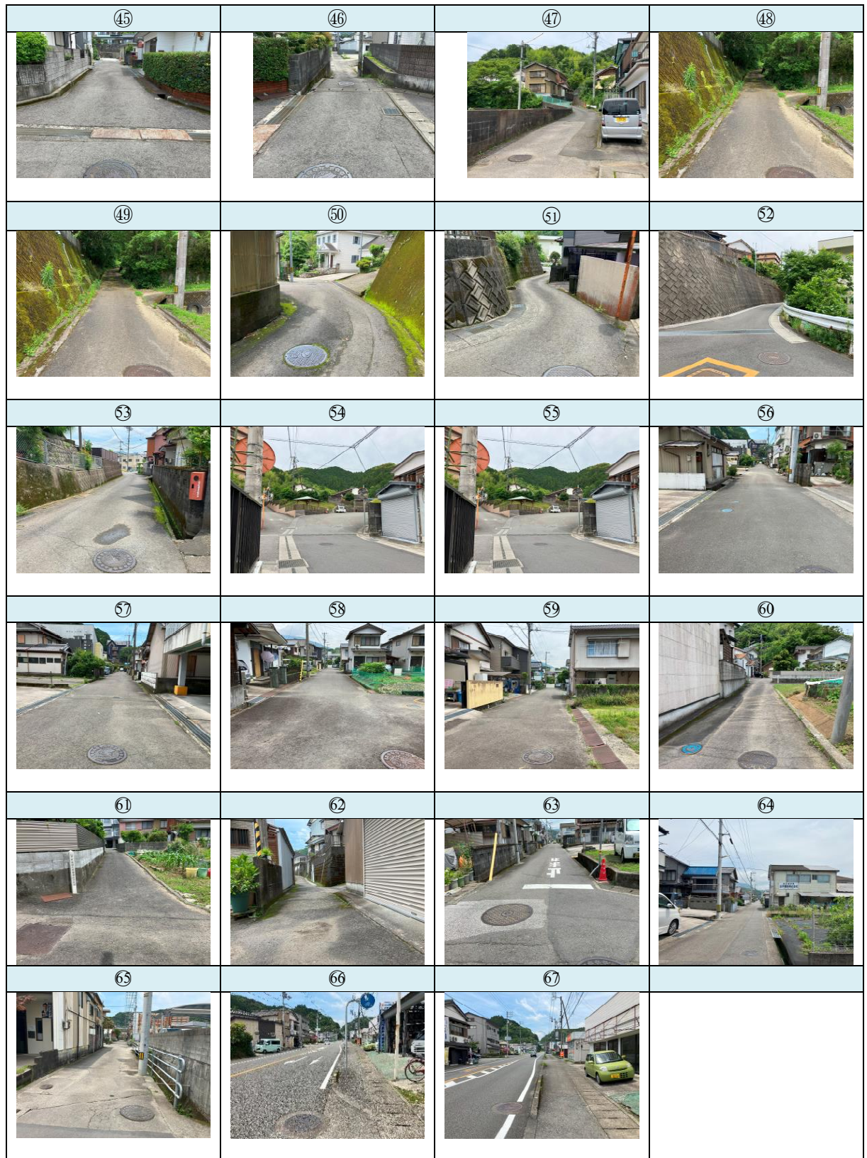
図 5-5 大雨後の巡視 (3/3)
