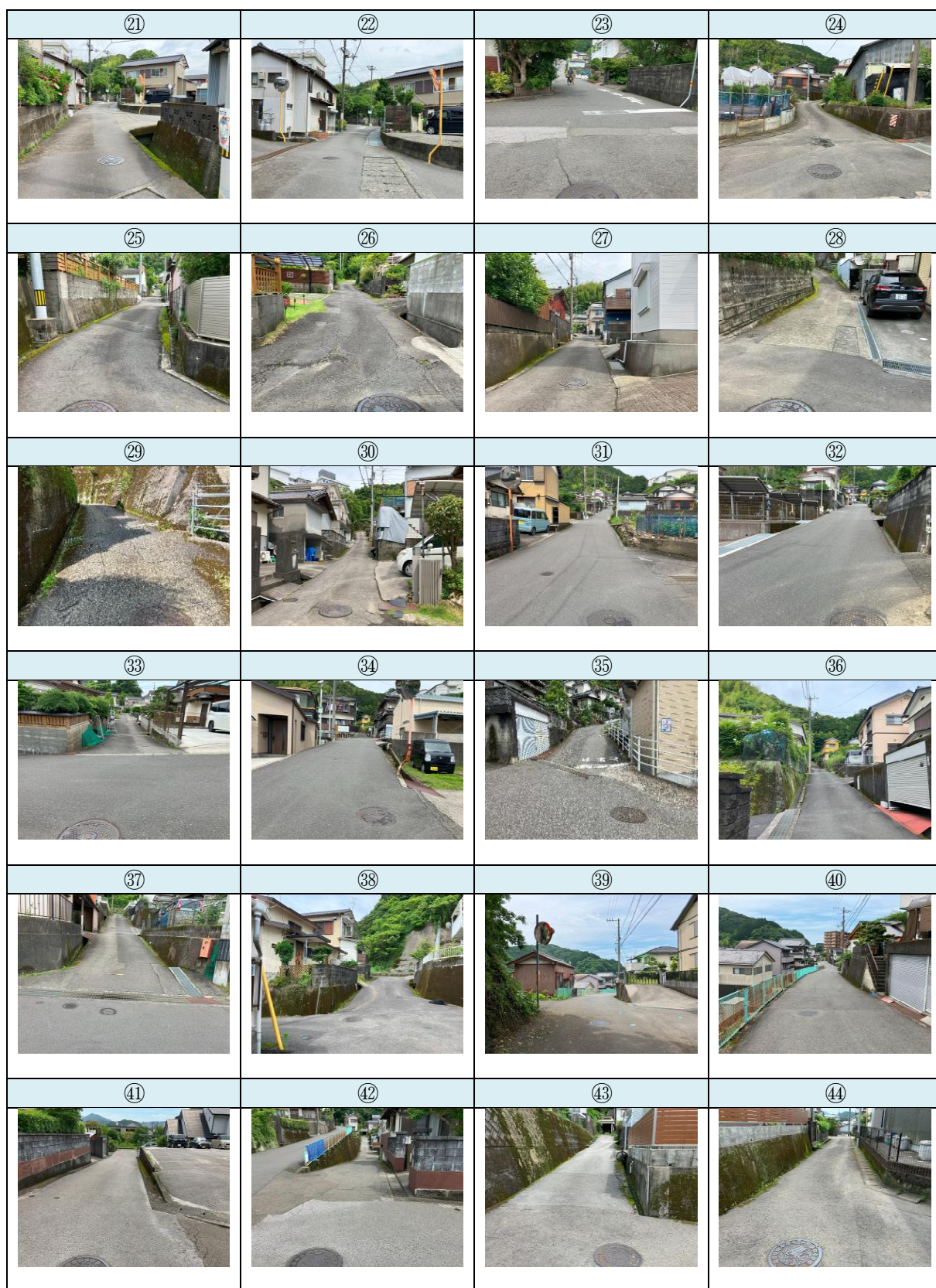
図 5-4 大雨後の巡視 (2/3)
