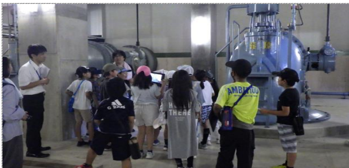
雨水ポンプ場の説明 (上下水道課担当者)
