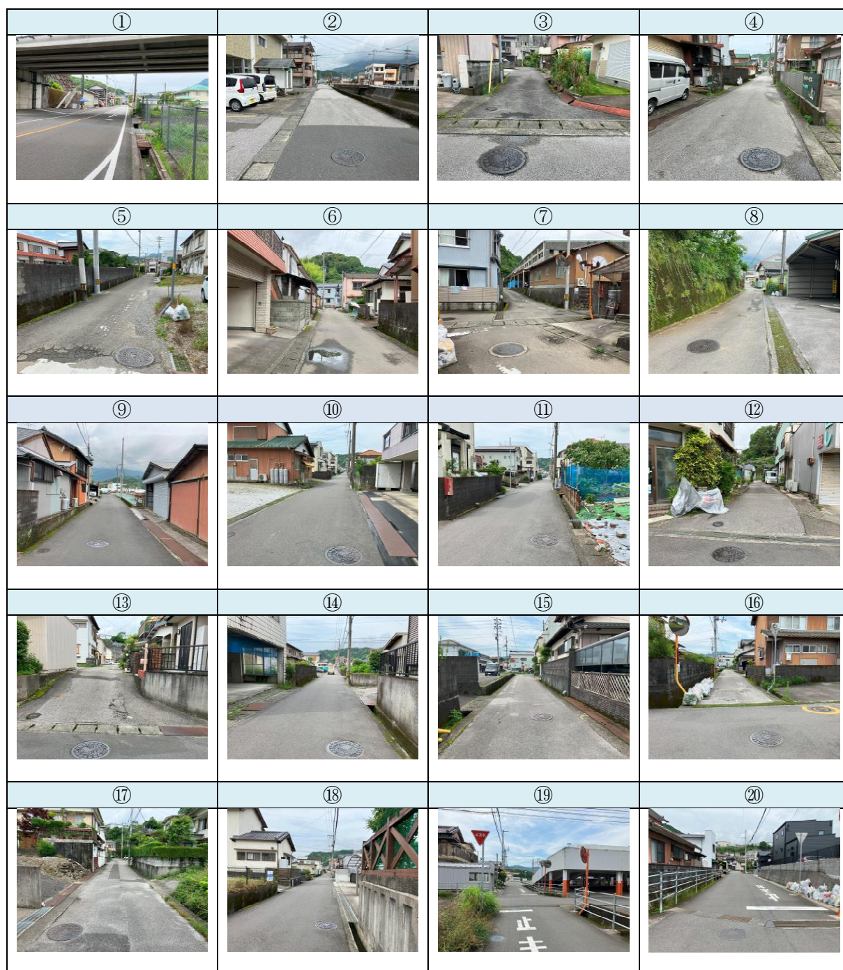
図 5-3 大雨後の巡視 (1/3)
