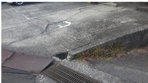
51(S374)付近_写真①
