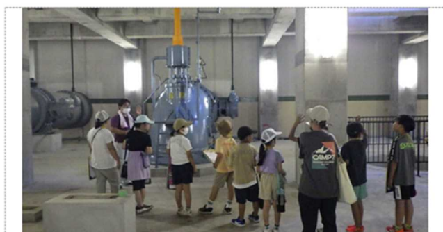
雨水ポンプ場の説明 (上下水道課担当者)
