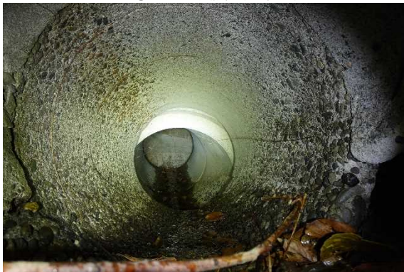
写真⑤ 横断管内部（φ500程度）
