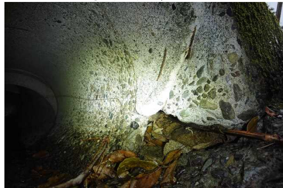
写真⑥ 横断管内部（φ500程度）
