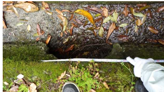
写真④ 横断管（φ500程度）
