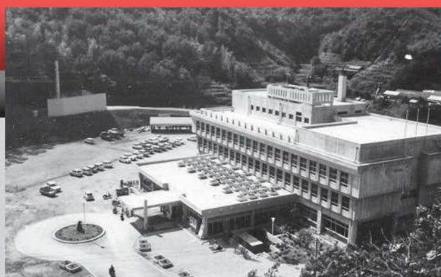
昭和43年11月 須崎市庁舎完成
