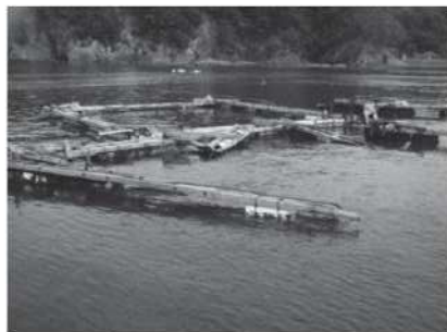
津波により大破した養殖小割いかだ
