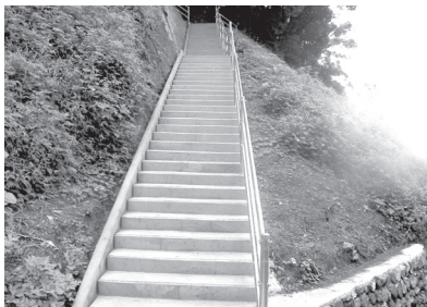
整備された避難道
