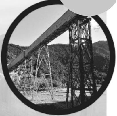
須崎市内で見かけるこの「ナゾ」の建物。正体は日本一の長さを誇る日鉄鉱業の石灰石を運ぶ、ベルトコンベアです。遠く仁淀川町の鳥形山から須崎港までの道のりを繋いでいます。昭和46年に生産を開始して以来、国内はもとより海外にも出荷され、生産能力は年産1400万吨と日本のトップレベルの規模を持っています。
