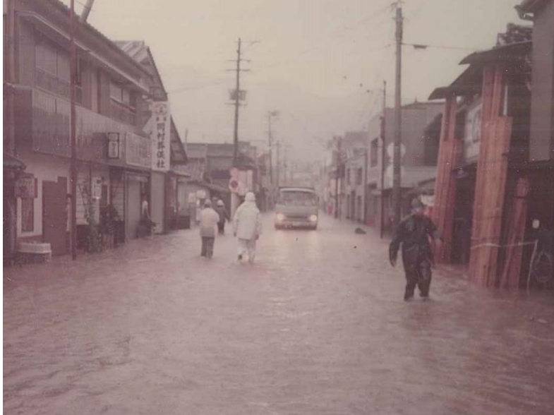
写真3 須崎駅前の浸水被害（昭和 50 年台風 5 号）
