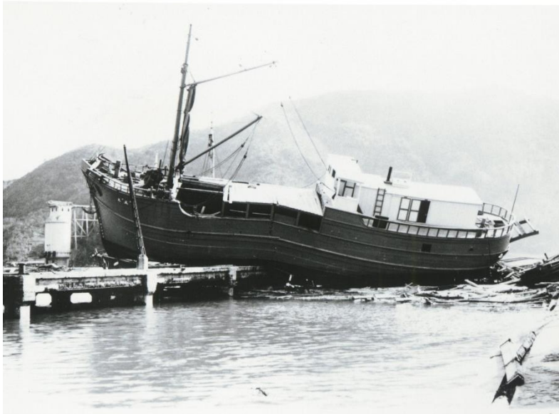
写真1 港町棧橋に打ち上げられた船舶（昭和南海地震）
