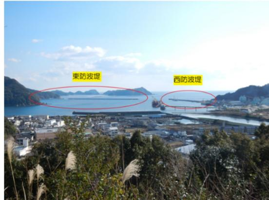
これにより、津波が海岸堤防を越える時間を遅らせ、背後地の住民等が避難する時間を確保するとともに背後地の浸水被害を軽減することが可能にはなるが、防波堤は津波を完全に防ぐものではなく、津波発生時には、避難場所に必ず避難する必要がある。
